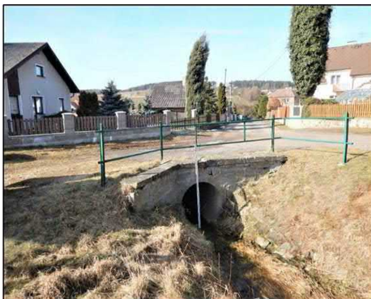
Obrázek 5: Zatrubnění svodnice vstupující do intravilánu obce Zaječov v lokalitě Hamburk
